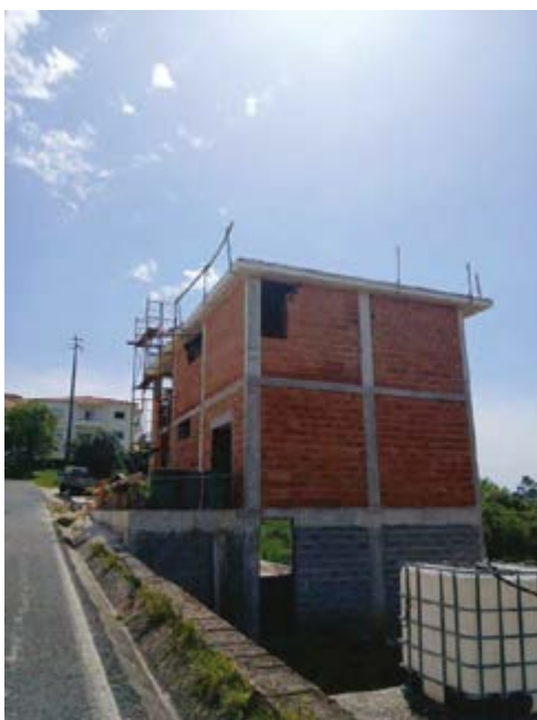
Imagem 02- Fotografia da obra
